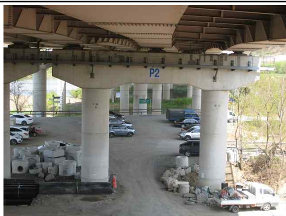
교각 P2 전경
