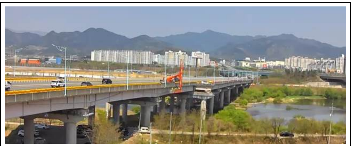
<그림 3.1> 범안대교 측면 전경
