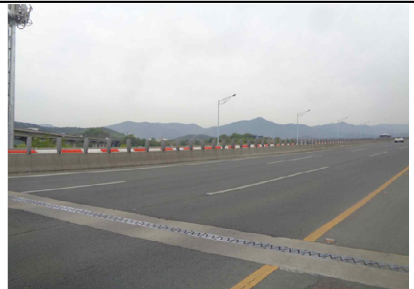
내측 중분대 및 차광판 전경
