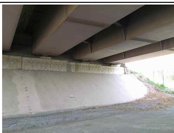
교대 A2 전경
