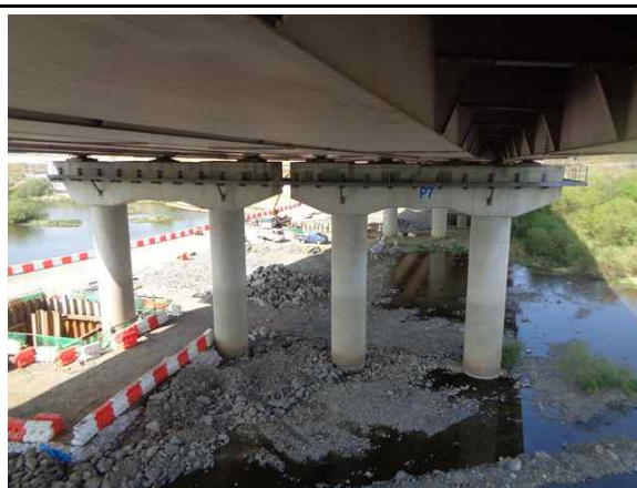
교각 P7 전경
