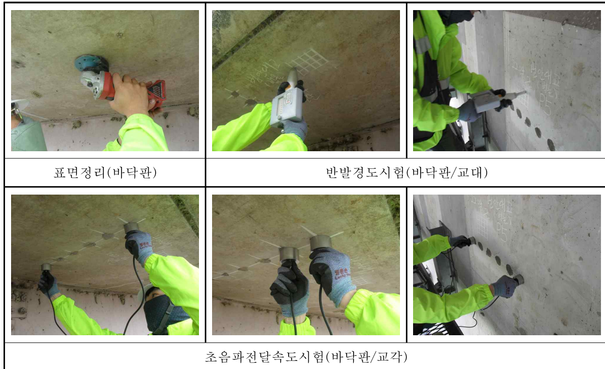
<그림 3.7> 콘크리트 강도조사
