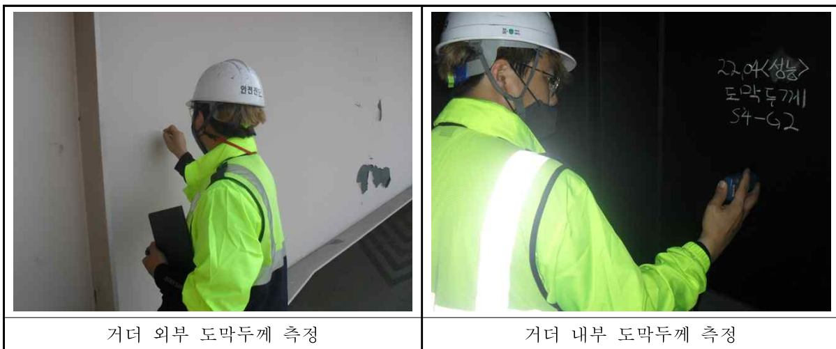
<그림 3.21> 도막두께 측정
