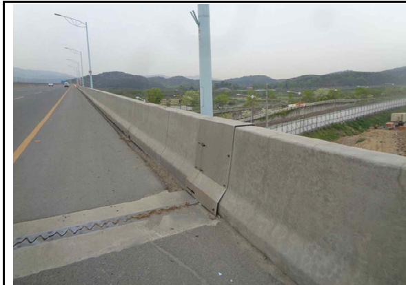
외측 방호벽 및 오물투척 방지망 전경
