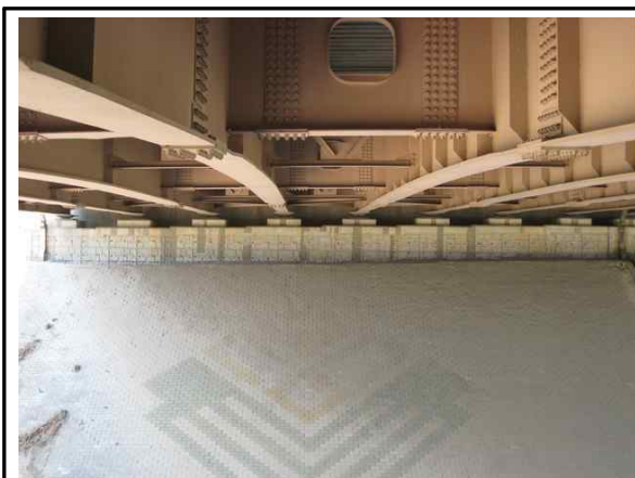
교대 A1 전경
