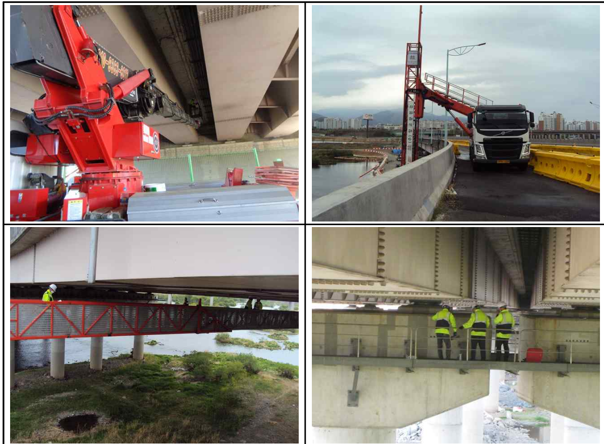
<그림 3.2> 고소작업차, 교량점검차, 도보점검 등을 이용한 외관조사
