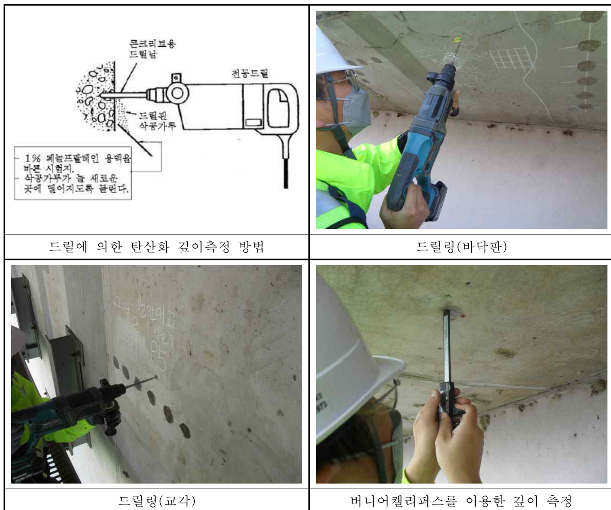
<그림 3.12> 드릴에 의한 탄산화 깊이 측정
