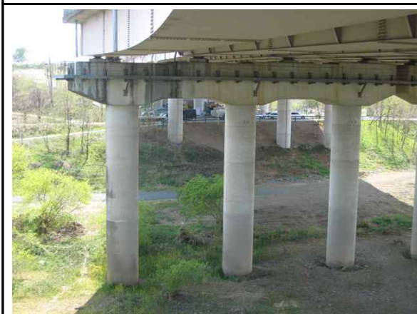
교각 P4 전경
