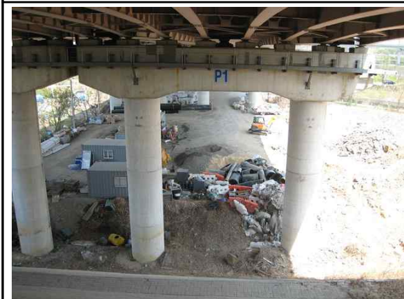
교각 P1 전경
